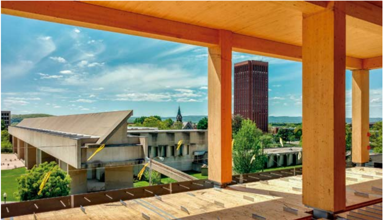
Figura 5: Proyecto UMass Design Building realizado con CLT (Nordic Structures, Amherst, EE.UU., 2017). Se pueden ver los conectores HBV que favorecen la colaboración entre los tableros CLT y el hormigón armado (se trata de una solución costosa debido a la necesidad de emplear resinas). Fotografía: Nordic Structures.
