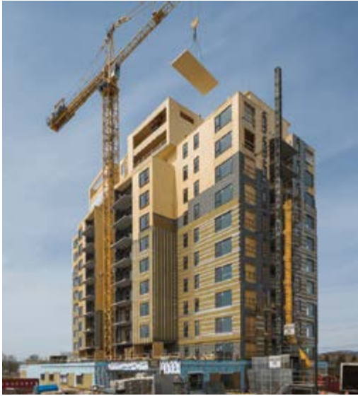
Figura 3: El proyecto Origine (Nordic Structures, Quebec, en construcción) propone una torre de viviendas de 13 plantas. Mientras una planta de hormigón armado sirve de cimiento, las doce plantas superiores están totalmente construidas con tableros CLT. En el detalle se aprecia un tablero CLT especialmente concebido para conformar la caja del ascensor y recibir las cargas laterales. El sistema de cerramiento realizado con tableros CLT propone paneles que cubren la cara de tres plantas. Llaves de cortante de acero han sido utilizadas para asegurar la transferencia de cargas de un panel a otro. El cerramiento exterior es simple: revestimiento exterior, piel metálica, aislamiento en paneles de fibra, membrana de estanqueidad adherente y CLT. Fotografía: Nordic Structures.
