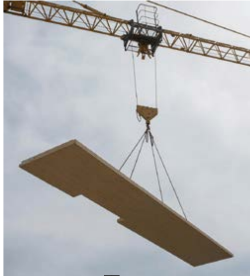
Figura 3: El proyecto Origine (Nordic Structures, Quebec, en construcción) propone una torre de viviendas de 13 plantas. Mientras una planta de hormigón armado sirve de cimiento, las doce plantas superiores están totalmente construidas con tableros CLT. En el detalle se aprecia un tablero CLT especialmente concebido para conformar la caja del ascensor y recibir las cargas laterales. El sistema de cerramiento realizado con tableros CLT propone paneles que cubren la cara de tres plantas. Llaves de cortante de acero han sido utilizadas para asegurar la transferencia de cargas de un panel a otro. El cerramiento exterior es simple: revestimiento exterior, piel metálica, aislamiento en paneles de fibra, membrana de estanqueidad adherente y CLT. Fotografía: Nordic Structures.
