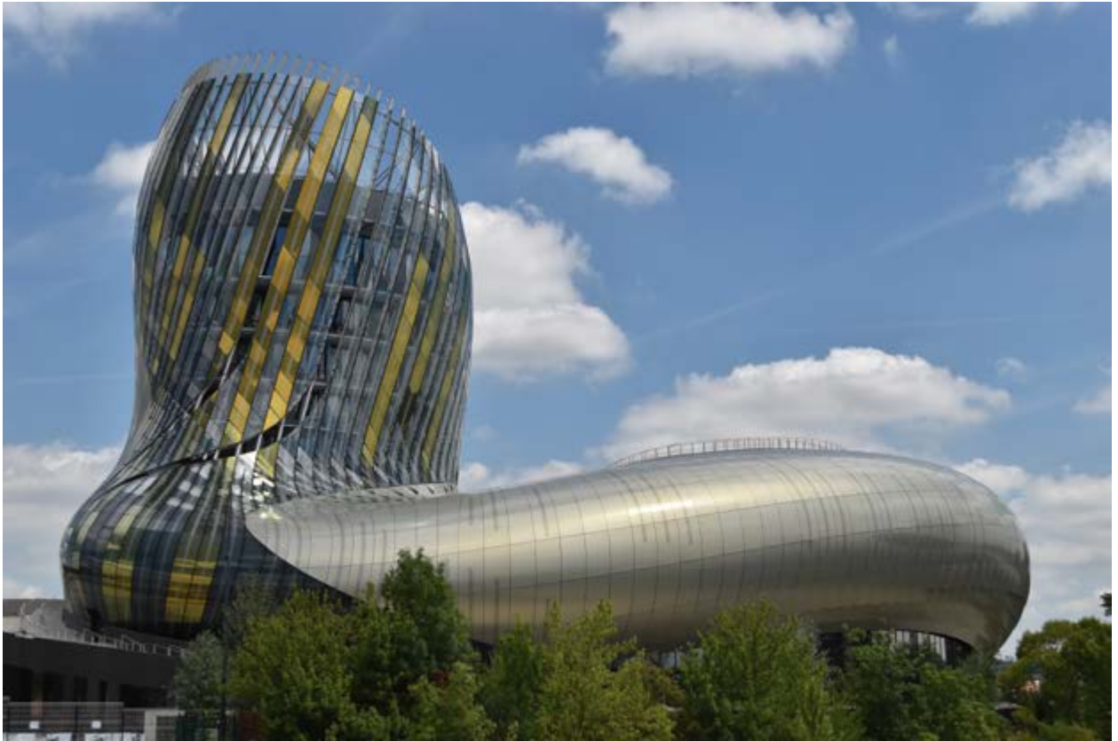
Figura 2: La impresionante estructura de madera laminada encolada de la Ciudad del Vino en Burdeos, diseñada por X-TU, propone superficies curvas fáciles de obtener con dicho material. Una laca traslúcida blanca fue empleada para dulcificar la presencia de la madera pero manteniendo el calor del material. Las conexiones se pensaron para reducir su presencia al mínimo y así mantener la limpieza formal del edificio, terminado en 2016. Fotografía: Pierre Blanchet.
