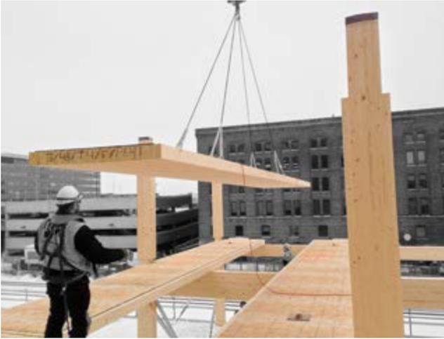
Figura 2: Los paneles de madera contralaminada usados en conjunto con MLE permiten un cambio de escala en la construcción de madera. Fotografía: StructureCraft, gentileza de Michael Green Architecture.
