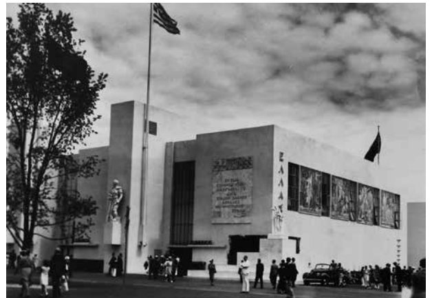
Exterior del pabellón griego en la Feria Mundial de Nueva York de 1939, con una copia del Hermes de Praxiteles en la esquina derecha. Cortesía de Irana y Aggelos Moretis. The Alexandra and Dimitris Moretis Personal Archives.
