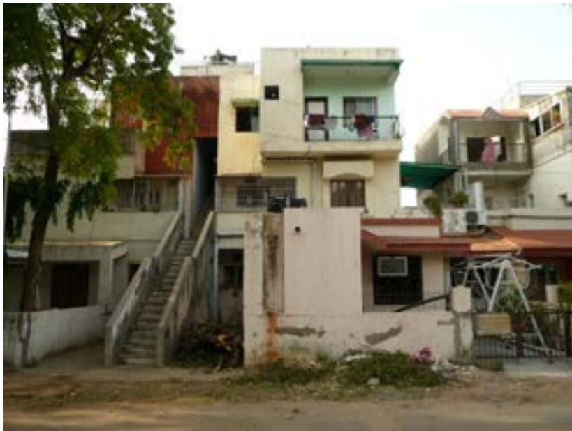
La "Colonia LIC" en Ahmedabad. Proyecto ejecutado por B. V. Doshi en los años ochenta. Doshi, uno de los arquitectos más prominentes de India, trabajó con Le Corbusier en Francia durante siete años (fue su asistente en algunos proyectos en India). La "Colonia LIC" fue diseñada para grupos de ingresos mixtos y permitió a los residentes transformar la arquitectura original para satisfacer sus necesidades, medios y aspiraciones. La mayoría de las unidades han sido modificadas completamente a través de los años, produciendo un barrio diverso.
