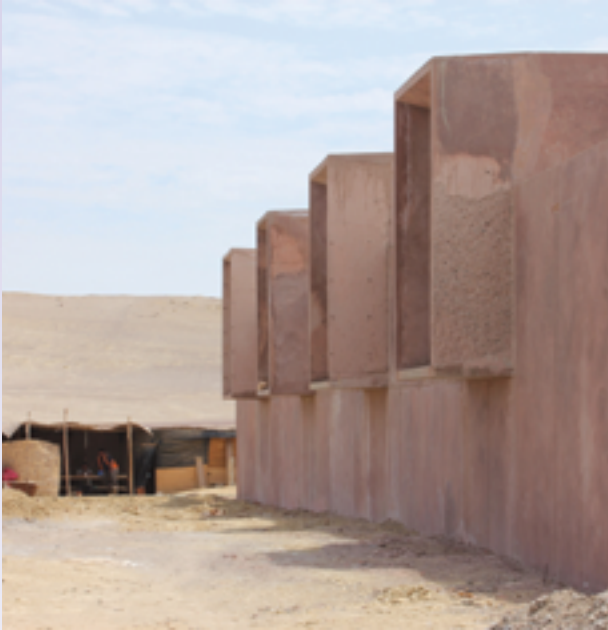
Museo Paracas, de Barclay y Crousse Arquitectura (2012). El paisaje y su historia detonaron la aproximación a la espacialidad, la materia y su imagen. La ausencia de elementos que indiquen la escala humana hace que las construcciones sigan los efectos visuales que propone el desierto.
