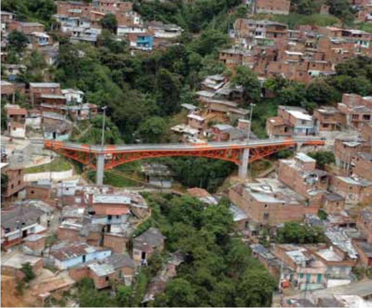
Puente "El mirador aéreo", Medellín, Colombia.
