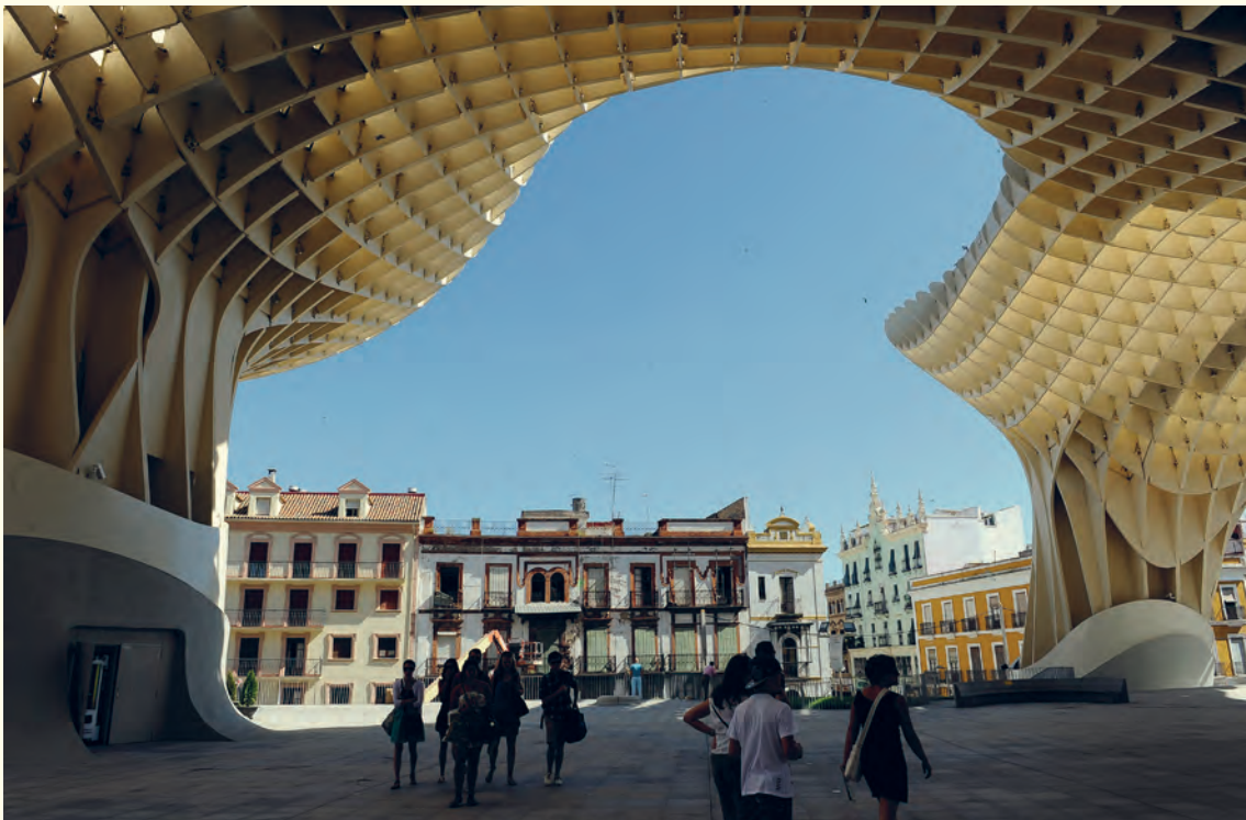
Figura 1: Estrategia de fabricación: "Seccionamiento estructural paramétrico" por cortadora láser. Metropol Parasol, Sevilla, España, diseñado por J. Mayer (2011). Arriba: Vista general. Abajo: Vista de la estructura de grilla paramétrica. Fuente: Jürgen Mayer. Fotografías: Nikkol Rot Holcim.
