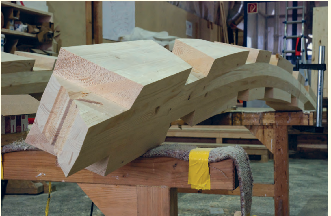
Figura 2: Estrategia de fabricación: "Diseño estructural compuesto" por CNC. Nine Bridges Golf Club House, Yeosu, Corea del Sur (2008), diseñado por Shigeru Ban y Designtoproduction. Arriba: Vista general de la estructura del techo. Abajo: Detalle del componente estructural fabricado con CNC. Fuente: Fabian Scheurer.
