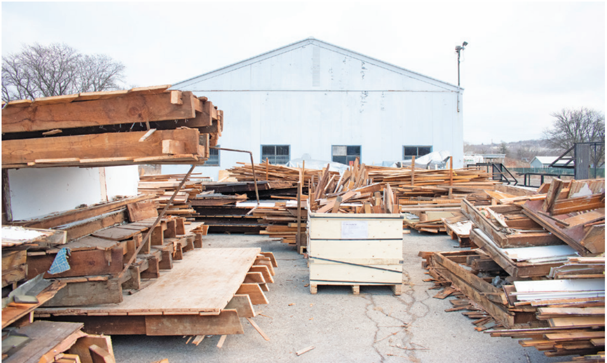
ARRIBA Fotografía aérea del proceso de deconstrucción de edificios en "Catherine Street Commons Deconstruction Project". ABOVE Aerial photograph of the building deconstruction process at 'Catherine Street Commons Deconstruction Project'. © Jason Koski/UREL.
