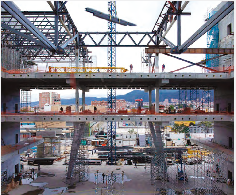
Proceso de construcción del centro de convenciones Ágora Bogotá (Estudio Herreros en colaboración con Daniel Bermúdez Arquitectos, Bogotá, 2016). Fotografía: Javier Callejas.
