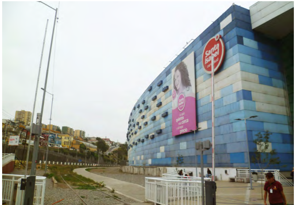
Vista del estado actual de la fachada terrestre del Mall del Pacífico desde el encuentro de Avenida Barros Luco y Avenida Centenario, el acceso tradicional norte a la ciudad portuaria, 2015. Fotografía: Daniel Montoya. Taller San Antonio, FAU, Universidad de Chile.
