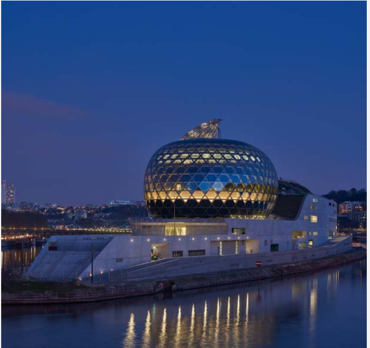
La Seine Musicale (Shigeru Ban Architects + Jean de Gastines, Paris, 2017). Vista exterior de malla hexagonal construida con elementos de madera laminada encolada. Fotografía: Didier Boy de la Tour.
