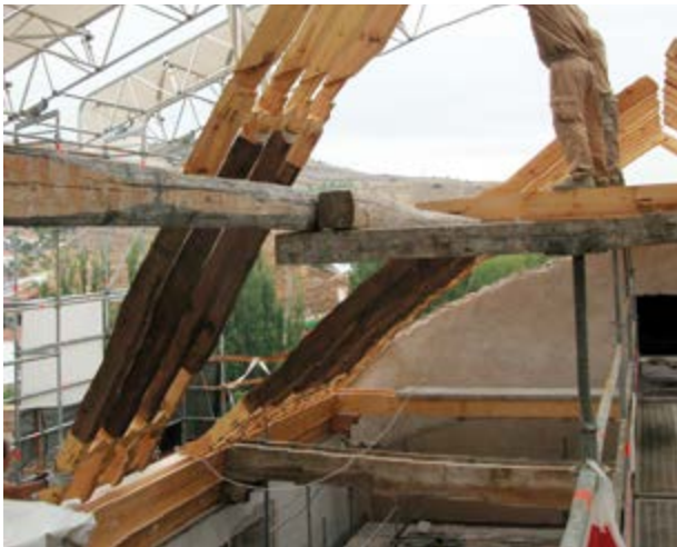
Figura 11: Un conjunto de cuatro pares, debidamente afianzados entre sí con varios peinaos, se apoya en el estribo, cuidando que sus patillas impidan su retroceso. A continuación se encajan las gargantas de los pares en los corneuelos de los nudillos del almizate, que previamente se había puesto en su lugar mediante un ligero andamiaje apoyado en los tirantes de la armadura. Fotografías: Enrique Nuere.
