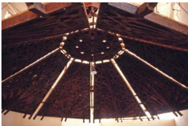
Figura 9: En esta ochava de la iglesia del antiguo Convento de la Merced, de Granada (s. XVI), las ruedas de diez forman parte del encuentro de los faldones con el almizate, para lo que el tracista aumenta el ángulo entre brazos, sin que sea apreciable la irregularidad. La misma armadura nos muestra durante su montaje las calles de limas y la unión sin completar entre faldones y almizate, zonas que permitían realizar ajustes de la lacería una vez en su lugar los paños prefabricados. Fotografías: Enrique Nuere. Figure 9: In this octagonal collar plane of the church of the old Convent of la Merced, in Granada (XVI C.), the ten fold rosettes are part of the joint of the roof planes with the collar plane, for which the designer increases the angle without the irregularity being noticeable. The same framework shows us during its assembly the space between the hip rafter and the incomplete joint between roof planes and the collar plane, areas that allowed adjustment of the lace once the prefabricated pieces were in place. Photographs: Enrique Nuere.
