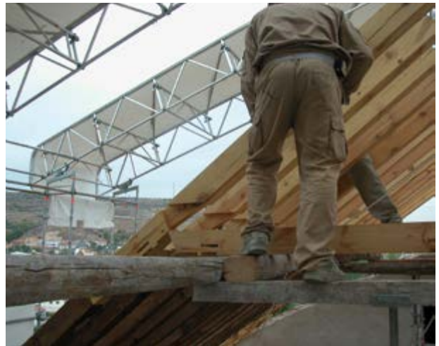
Figura 11: Un conjunto de cuatro pares, debidamente afianzados entre sí con varios peinaos, se apoya en el estribo, cuidando que sus patillas impidan su retroceso. A continuación se encajan las gargantas de los pares en los corneuelos de los nudillos del almizate, que previamente se había puesto en su lugar mediante un ligero andamiaje apoyado en los tirantes de la armadura. Fotografías: Enrique Nuere.
