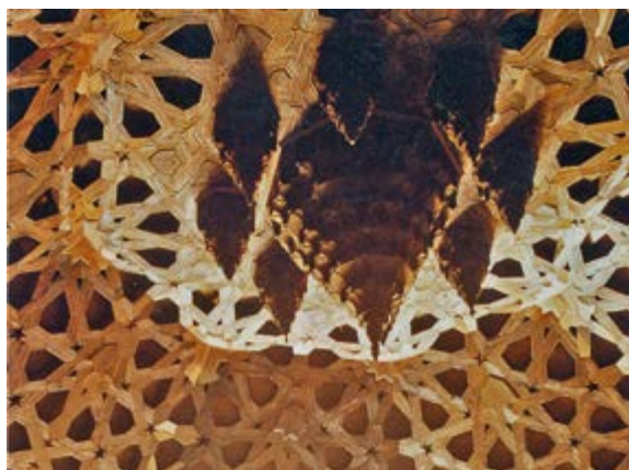
Figura 9: En esta ochava de la iglesia del antiguo Convento de la Merced, de Granada (s. XVI), las ruedas de diez forman parte del encuentro de los faldones con el almizate, para lo que el tracista aumenta el ángulo entre brazos, sin que sea apreciable la irregularidad. La misma armadura nos muestra durante su montaje las calles de limas y la unión sin completar entre faldones y almizate, zonas que permitían realizar ajustes de la lacería una vez en su lugar los paños prefabricados. Fotografías: Enrique Nuere. Figure 9: In this octagonal collar plane of the church of the old Convent of la Merced, in Granada (XVI C.), the ten fold rosettes are part of the joint of the roof planes with the collar plane, for which the designer increases the angle without the irregularity being noticeable. The same framework shows us during its assembly the space between the hip rafter and the incomplete joint between roof planes and the collar plane, areas that allowed adjustment of the lace once the prefabricated pieces were in place. Photographs: Enrique Nuere.
